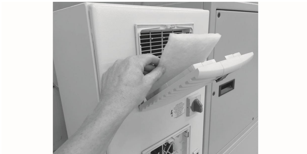
Рис. 57: Замена фильтра распределительного шкафа
